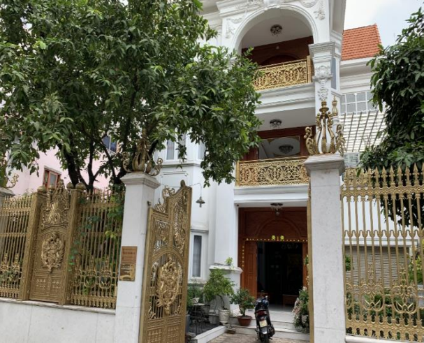
Co Lien Villa – DISTRICT 2 Jablotron Alarm
